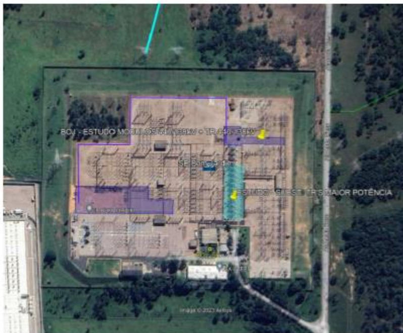
Figura 1 - Subestação Bom Jardim – Setor de 440kV
